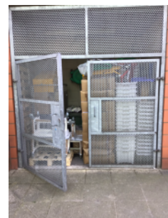
External bin store.
