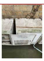
**BOX IS CRACKED AT TOP AND LEVER BROKEN**
